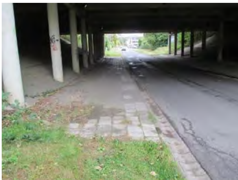
Foto: Viaduct Esdoornenlaan te Overijse
