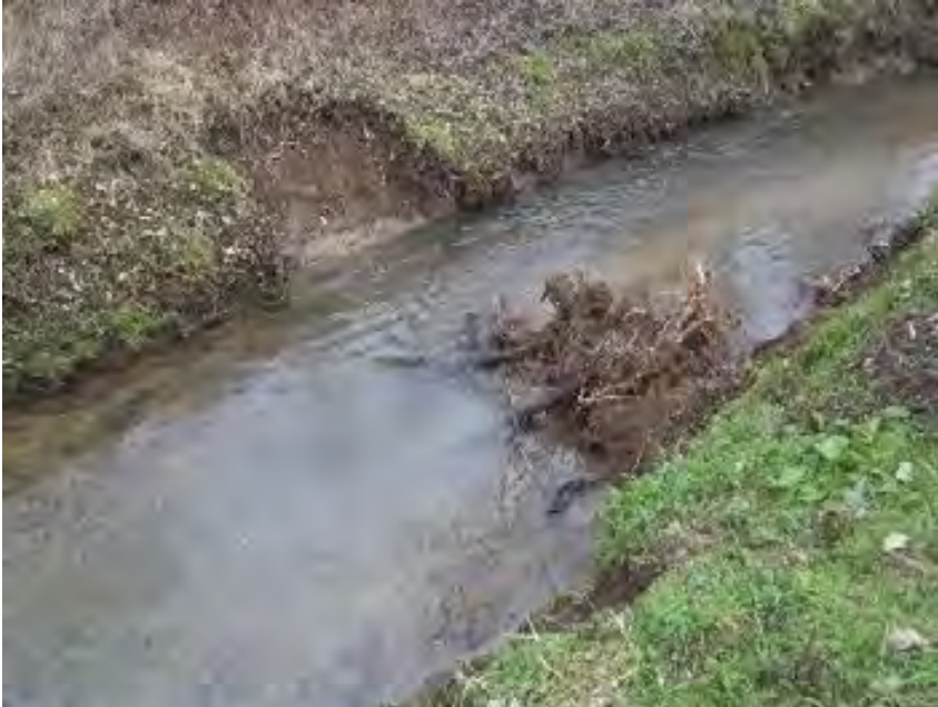
Afbeelding: Voorbeeld van het 'inbrengen van stroomdeflectoren' in een waterloop, ingewerkt in de oever
