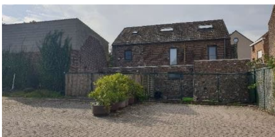
| Woningen nr. 24 tot 26 in de Raymond Lauwersstraat die uitgeven op het binnengebied van het onderzoeksgebied
