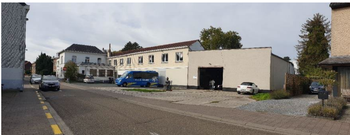
| Bestaande gebouwen op het onderzoeksgebied – gebouwen nr. 11, 13 en 15
