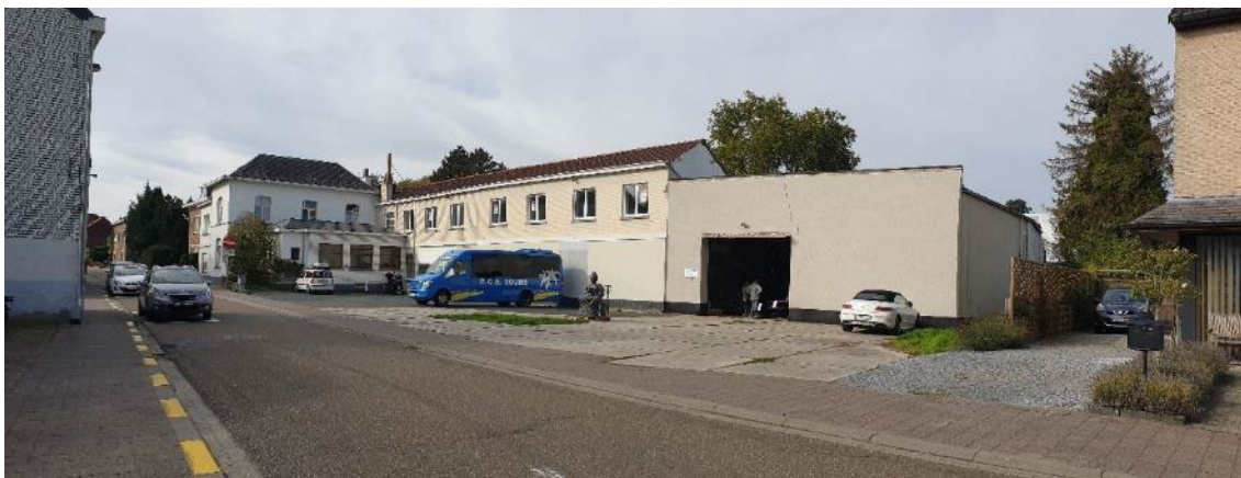
| Bestaande gebouwen op het deelgebied – gebouwen nr. 11, 13 en 15
