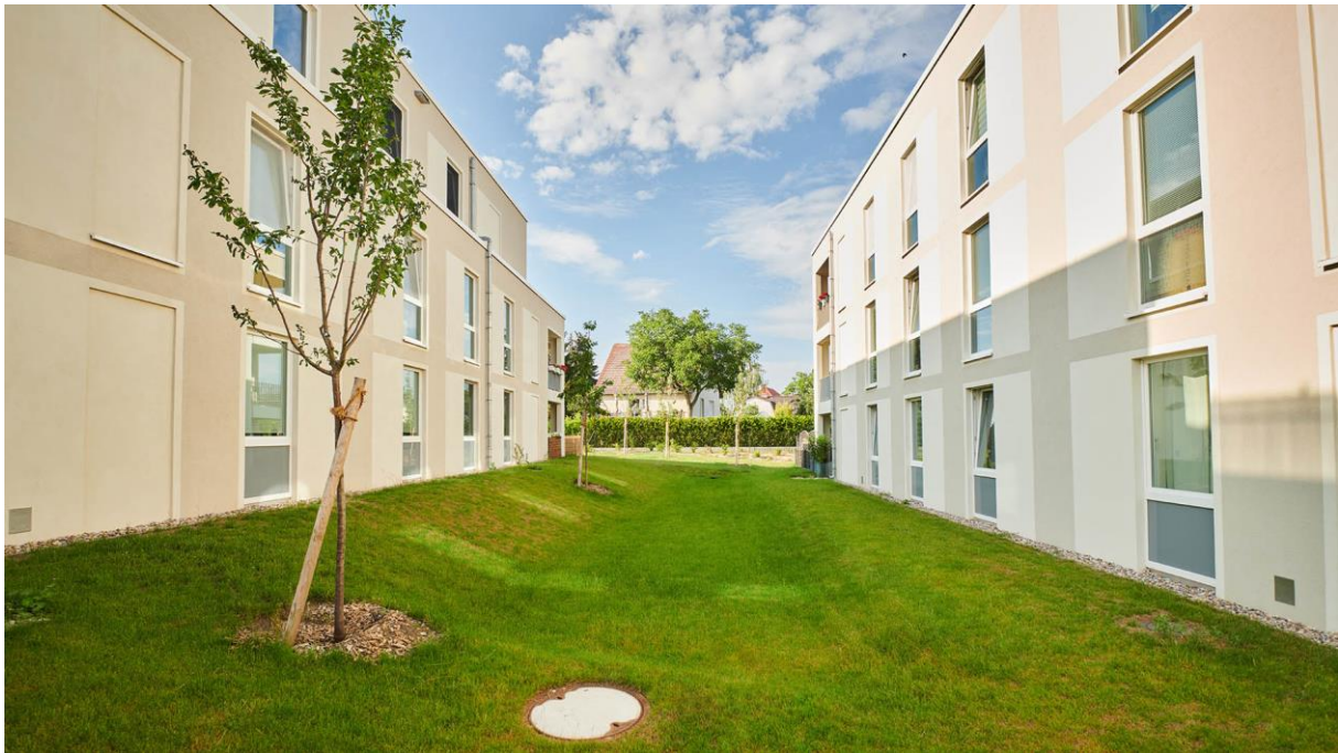
Figuur 51: Woonwijk Ortlofstrasse Residential quarter in Berlijn (Duitsland). Tussen deze twee bouwpercelen werd een verlaging aangebracht waarin water kan infiltreren. Dit voorkomt tevens dat water van het hoger gelegen linkergebouw zich over het oppervlak naar het lagere gebouw kan verplaatsen.
