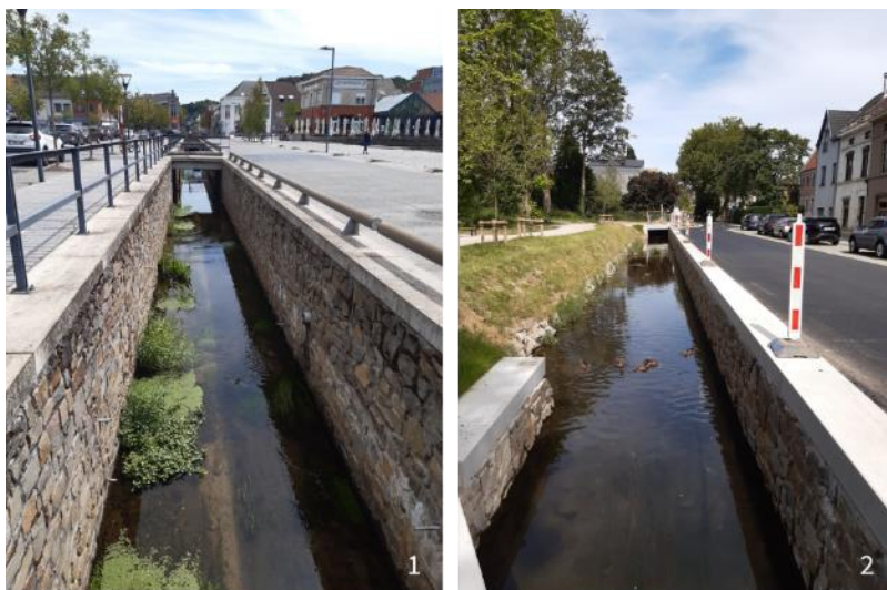
Figuur 11: Opgelegde IJse in het centrum van Overijse op twee locaties waar niet veel ruimte beschikbaar is. (1) Stationsplein; (2) J.Bt. Dekeyserstraat
