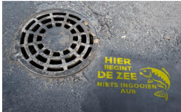
Figuur 52: Markering rioolputje “Hier begint de zee” (bron: mooimakers.be)
