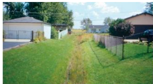
Figuur 35: Voorbeeld van een bovengronds stroompad op een perceelsgrens (© Homer, Alaska, USA)
