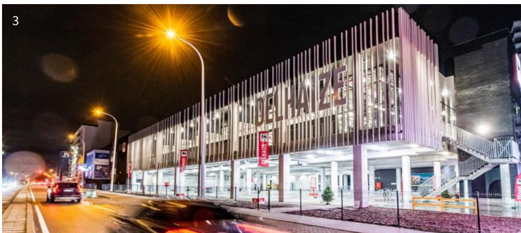
Figuur 10: Voorbeelden van gebouwen op palen waarbij de gelijkvloerse verdieping gebruikt wordt voor parking en toegang. (1 en 2) Nieuwbouw appartementsgebouw in de Nijverheidskaai in Rumst, op de oever van de Rupel; (3) Nieuwbouw supermarkt Delhaize in Mechelen
