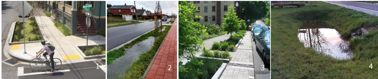
Figuur 18: Voorbeelden van lokale buffer- en infiltratievoorzieningen: (1) Infiltratiekom in verkeerselementen; (2) Verlaagde groenbermen; (3) Bestaande plantvakken met aaneengesloten infiltratiestroken; (4) Wadi naast de straat (Kouterstraat in Overijse)
