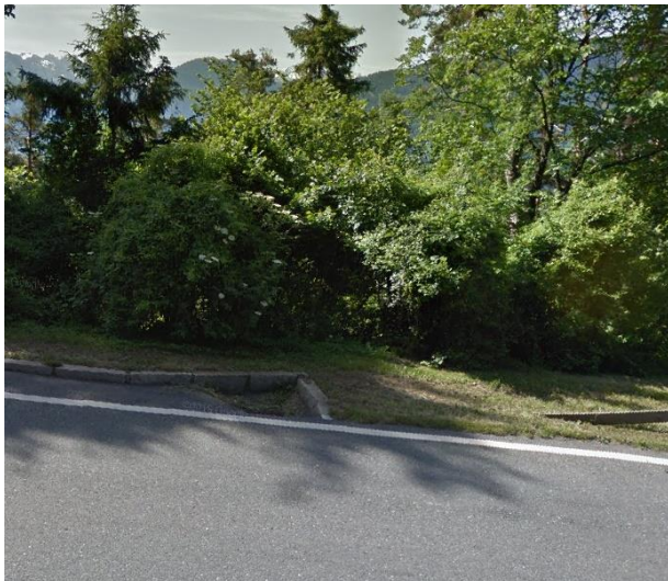
Figuur 33: Goed gebruik van een klassieke straatkolk langs een helling: het water wordt afgebogen van de rijbaan. Een boordsteen voorkomt dat het water de weg verlaat (omdat er in dit geval bebouwing is achter de zichtbare bomen). De kolk ligt verlaagd tegenover de omgeving en heeft een grote opening. De boordsteen erachter voorkomt dat snelstromend water terug de weg kan opstromen.
