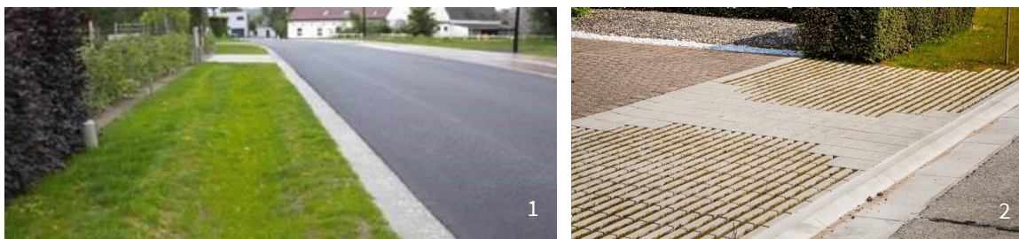
Figuur 9: (1) Verlaagde groenberm langs straat in Kruisem; (2) Verharding gecombineerd met waterdoorlatende verharding thv opritten.
