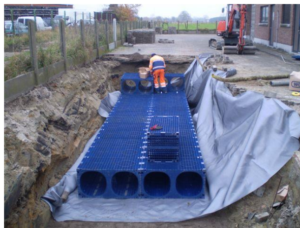
Figuur 29: Infiltratiekragen in aanleg.
