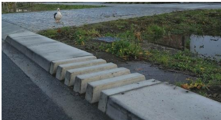
Figuur 16: Een voorbeeld van een boordsteen met spleten zoals toegepast in de Fortstraat in Mortsel (Bron: dbpubliekeruimte.info).
