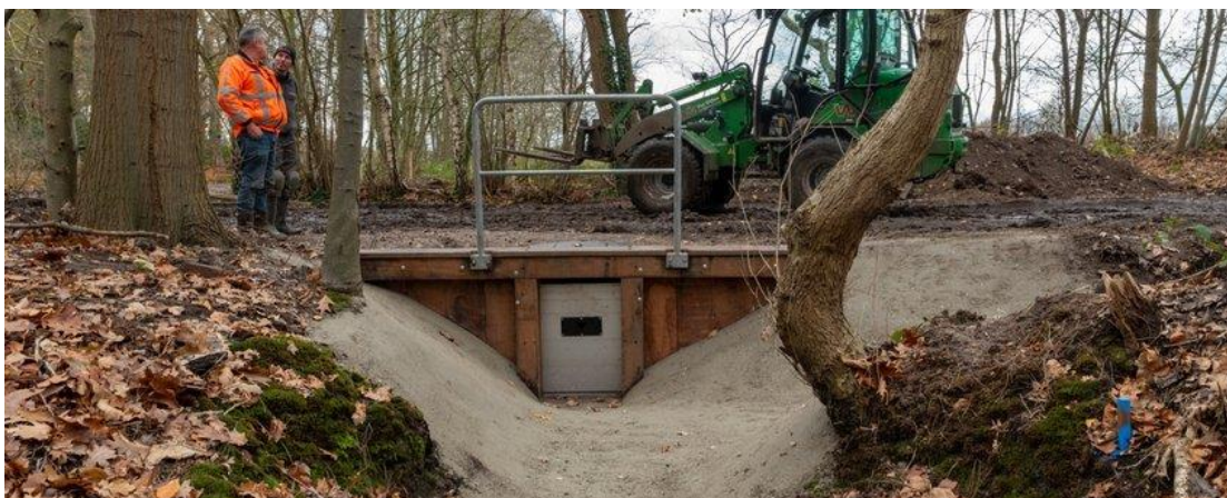
Figuur 42: Regelbare knijpstuw Ulvenhouts bos (Nederland) (bron: www.naturetoday.com )
