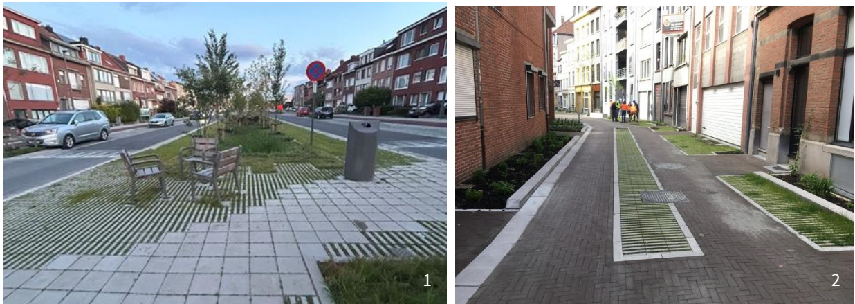
Figuur 13: Voorbeeld van de toepassing van halfverharding bij creatief straatontwerp in (1) Cathershoflaan in Merksem voor een zithoek; (2) Lange Ridderstraat in Antwerpen die ingericht is als een tuinstraat
