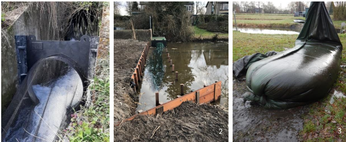
Figuur 44: Voorbeelden van een vuilfuik (opvangnet) net afwaarts lozingspunt riooloverstort (VMM, 2023 en © Sweco); (3) Gevulde vuilfuik, klaar voor ruiming (© Sweco)
